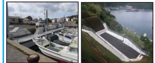
漁業作業の効率化と安全対策のための漁港整備（岸壁改良） 漁村における津波避難対策（避難施設、避難経路の整備）
