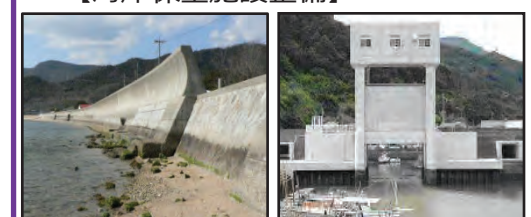
津波、高潮による被害を未然に防ぐため海岸堤防の整備を推進 津波・高潮対策としての水門整備
