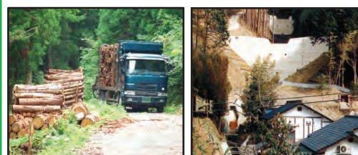
林道等の整備により効率的な間伐材等の搬出を実現 治山施設による山地災害の未然防止
