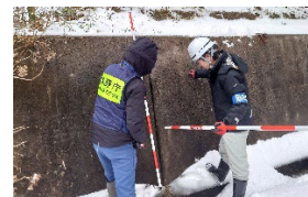
激甚災害後の治山施設の点検支援
