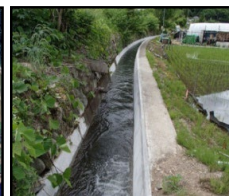
老朽化した用水路の整備・更新
