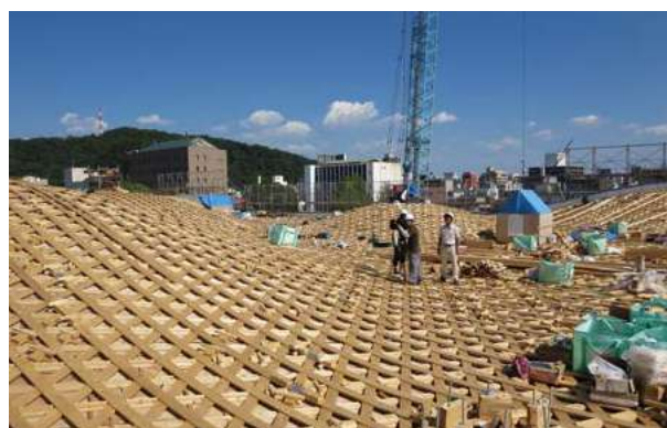
岐阜市立新図書館の屋根工事の状況
