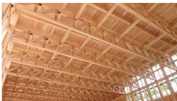
岐阜県木連が開発した木造平行弦トラスの建築例
